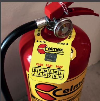
QUE CUENTEN CON UN COLLARÍN LOS EXTINTORES DE PQS DE PRESIÓN CONTENIDA DESPUÉS DE RECIBIR MANTENIMIENTO Y RECARGA EN CONFORMIDAD CON LA NOM-154-SCFI-2005
